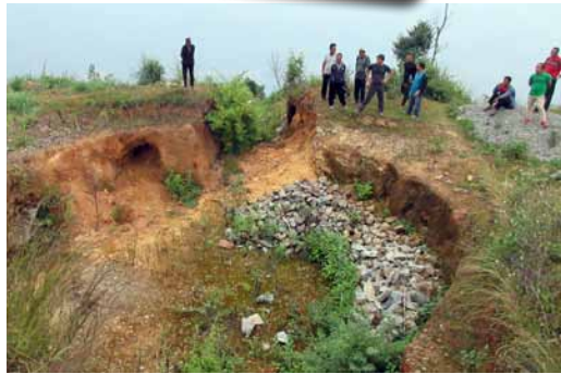
uitgravingen voor reservoir
