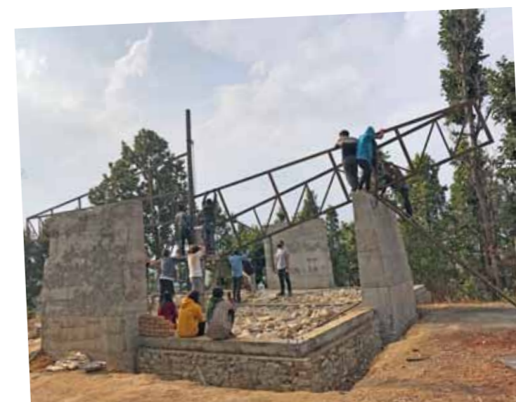
Het centrale spant wordt op z'n plaats gegeven, met man en macht!
