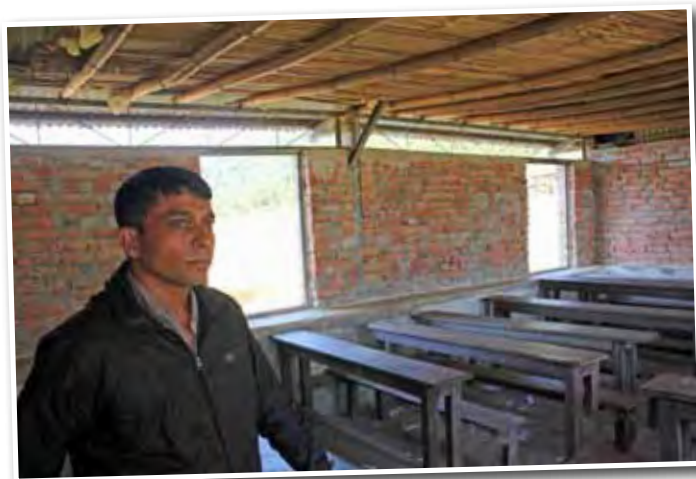
12 Sommige ingrepen zijn niet zo duur maar kunnen een klaslokaal aangenamer maken. CEPP-medewerker Keshav moedigt de leerkrachten aan om onder het metalen dak een isolerende bamboe laag aan te brengen.
