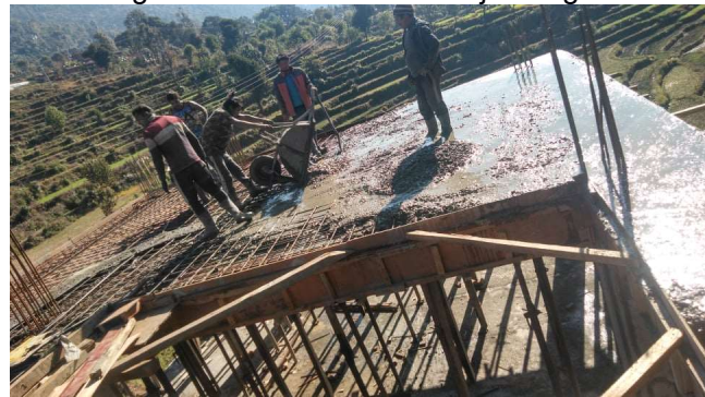
De betongietwerken voor het dak zijn aangevat
