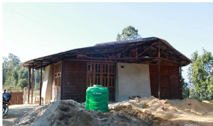
Zijkant van het schoolgebouw, met zicht naar de toegang tot het schoolterrein. Schrijnwerk (ramen en deuren) worden geplaatst
