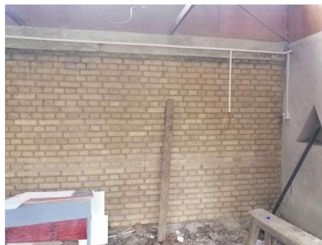
Uitvoering van eerste elektriciteitswerken
