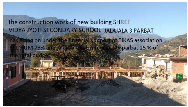
De betongietwerken voor het dak zijn aangevat
