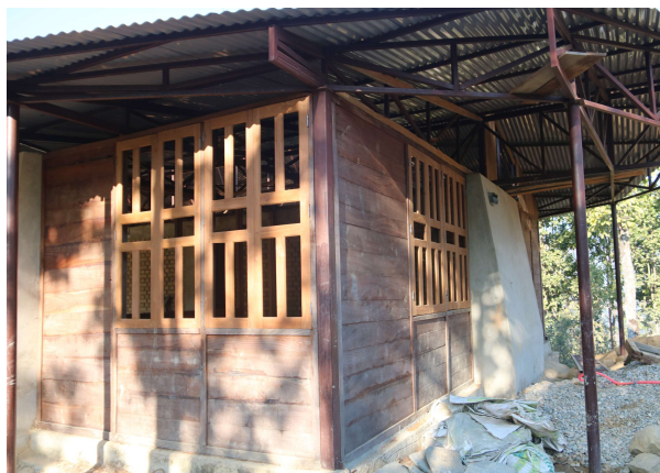
Detailfoto van de houten buitenwand & het nieuwe schrijnwerk
